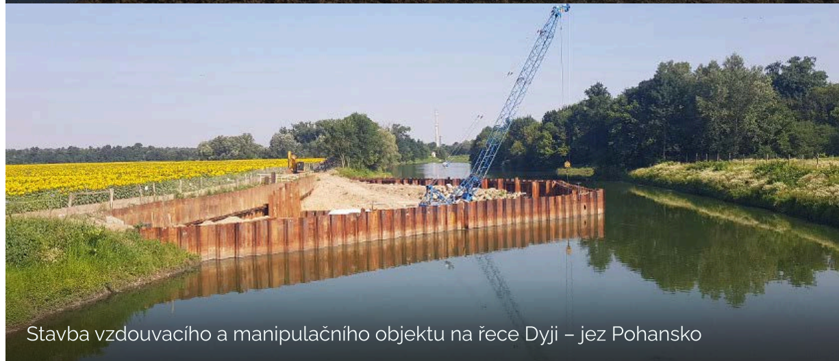
Revitalizační opatření v EVL Soutok – Podluží
