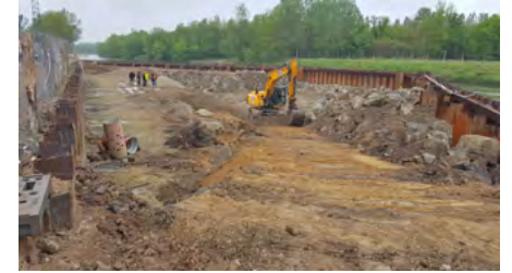
Výstavba jezu na řece Dyji
