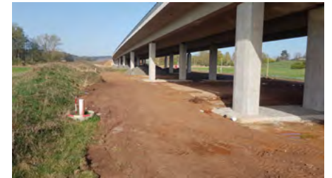
Biologický dozor na stavbě D6 Krupá, přeložka
